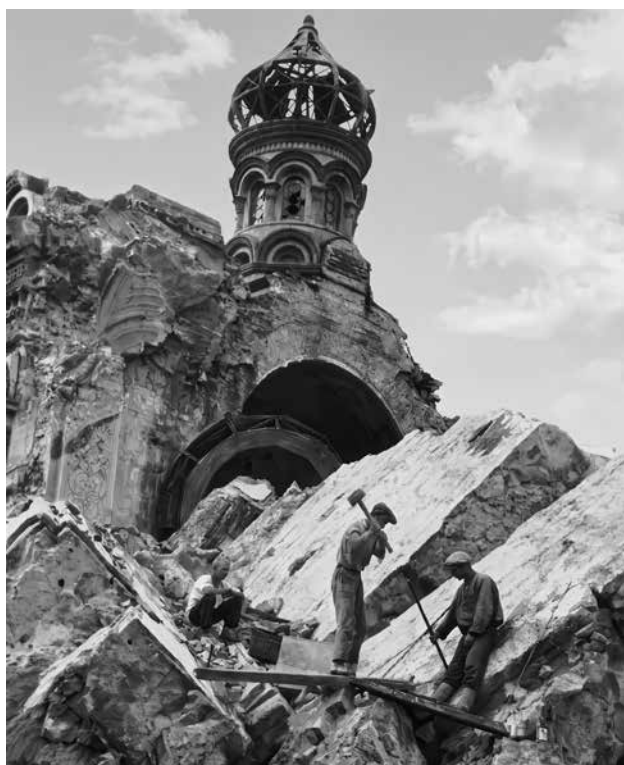
5. ბათუმის კათედრალის ნგრევა, დაახლოებით 1931, უცნობი ფოტოგრაფი. წყარო: შოთა გუჯაბიძის კოლექცია. 5. DEMOLITION OF THE BATUMI CATHEDRAL, AROUND 1931. UNKNOWN PHOTOGRAPHER. SOURCE: SHOTA GUJABIDZE COLLECTION.
