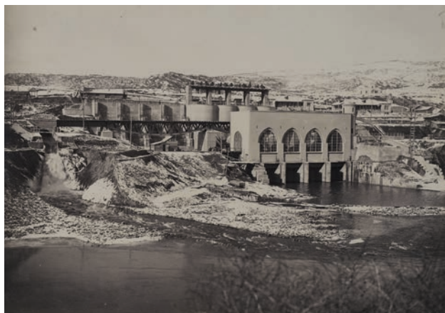
1. გაჭმის საგენერატორო სადგურის მშენებლობის პროცესი. ბაგრატ მიქელაძის ოჯახის არქივი. CONSTRUCTION OF ZAHESI POWER HOUSE. BAGRAT MIKELADZE'S FAMILY ARCHIVE.
